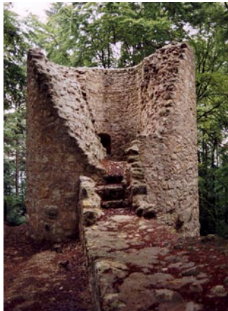
Turmruine der Burg Ehrenfels bei Beratzhausen.
